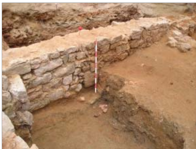
Alçat de la cara est de la part inferior del MR-23, un cop desmuntat el mur de tàpia
