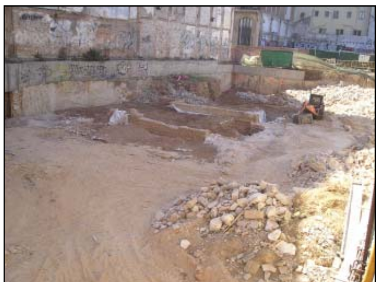
Protecció de les restes, amb cobertura de geotèxtil i terra, un cop desmuntats els murs de l'església i els espais situats al nord
