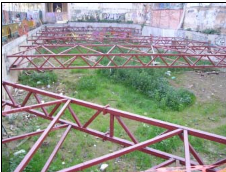
Vista general, de nord a sud, de la parcel·la a l'inici de la intervenció de l'any 2007
