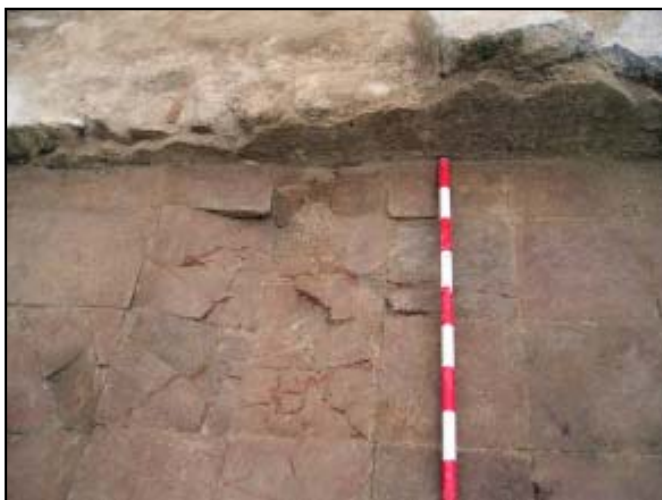
Possible impacte de bomba al PV-1
