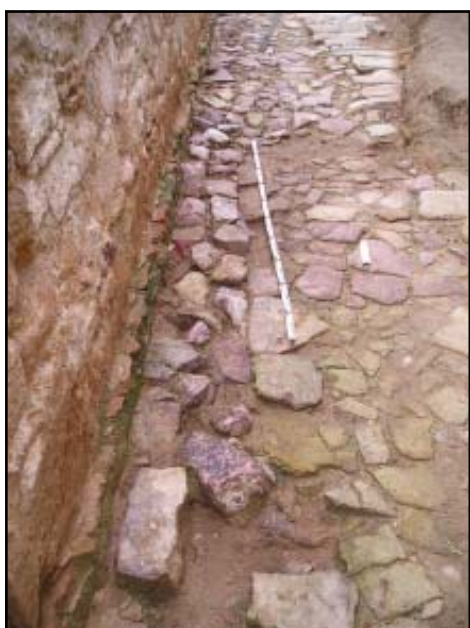
Reparació PV-13A del PV-13
