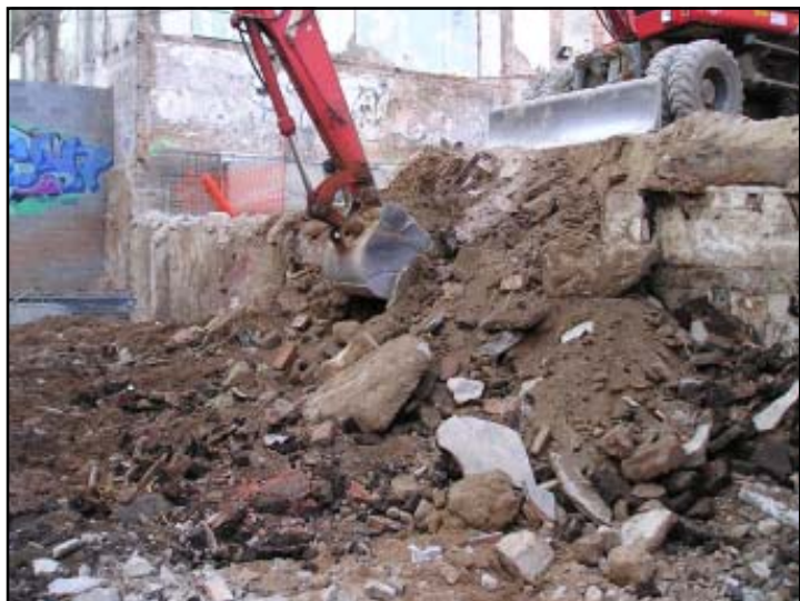
Treballs de desmuntatge i buidat de runa del soterrani de la zona central-sud
