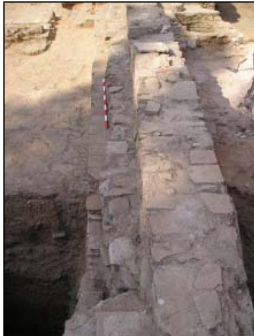
MR-9 i 32, amb les restes de l'estructura al damunt de la qual s'assentaven
